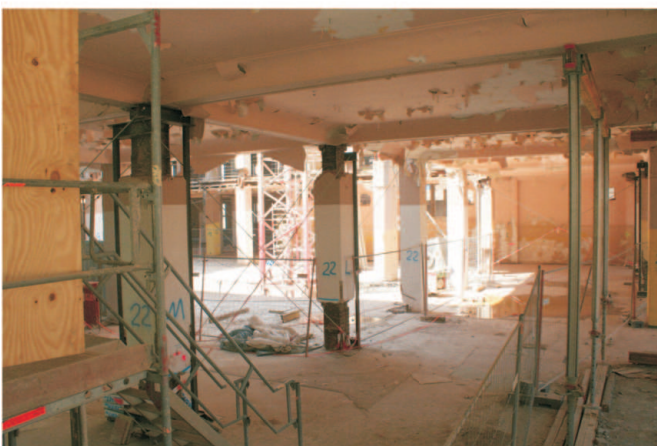
Hier sind Aussteifungen zu sehen, die zur Absicherung des Altbestandes dienen
