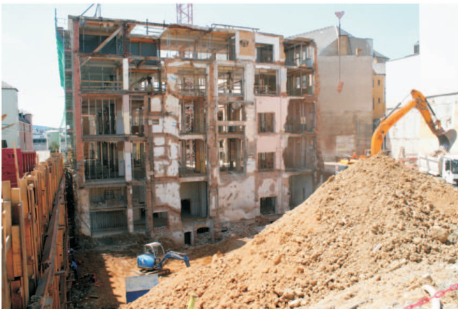
Rückbauarbeiten werden durchgeführt (Deckenfelder werden entfernt), um die Baufreiheit für Neubauteile (Treppenhäuser, Fahrstuhlschächte) zu schaffen.
