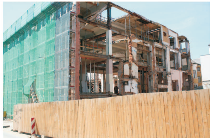
Rückbauarbeiten werden durchgeführt (Deckenfelder werden entfernt), um die Baufreiheit für Neubauteile (Treppenhäuser, Fahrstuhlschächte) zu schaffen.
