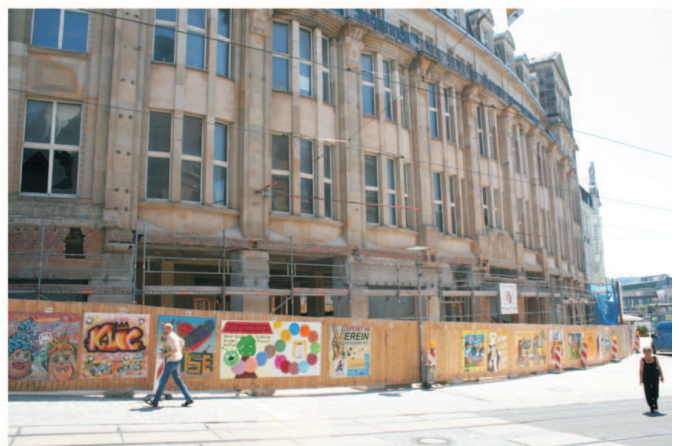
Es werden die alten Schaufensteröffnungen wieder hergestellt.
